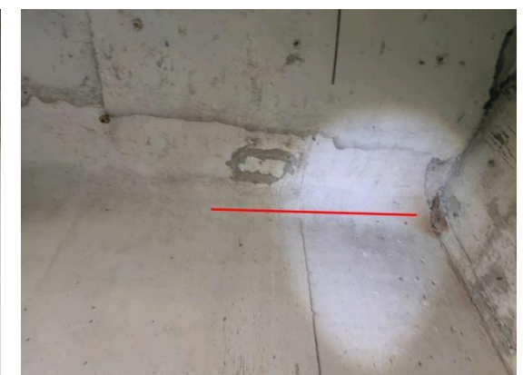
图 3-2：上甘店大桥（上行）5-1T 梁：距 4 号墩 0m 处，左翼缘板纵向裂缝；数量：1 条，长度：0.8m，宽度：0.14mm。
